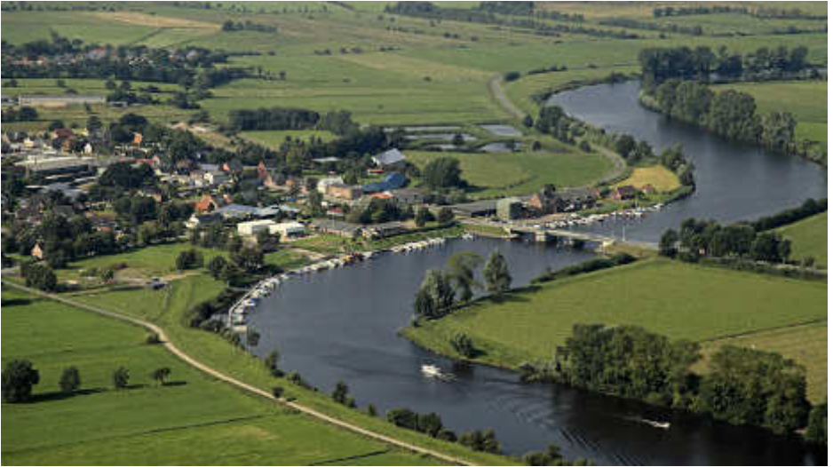
Klappbare Eiderbrücke in Pahlen / Klapbro over Ejderen i Pahlen / Folding Eider bridge Pahlen
